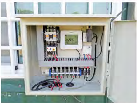
圖2. 研成之無線焚風感測控制系統
