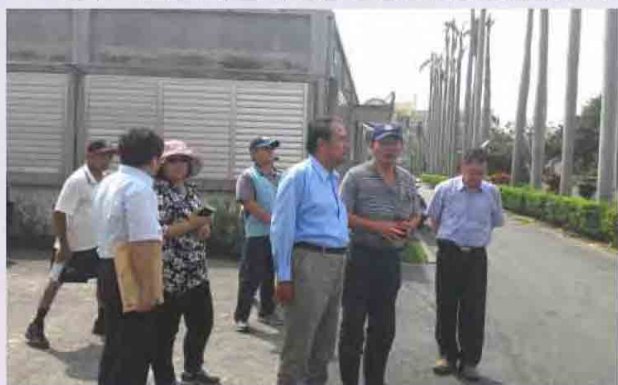
曹主委由本場場長陳信言陪同視察場區，關心建物及設施損害情形。
