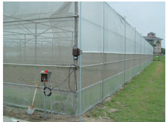
圖1. 鍍鋅鐵搭架，水平棚架結構網室。
