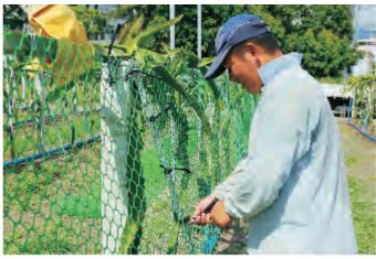
步驟3.使用萬能網(耐日曬之六角形大孔目塑膠網)作為斜面固定網(左圖), 並以倍力繩(黑色塑膠繩)或其他繩材將其固定於斜插錏管上(右圖)。
